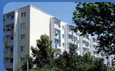
Aufzug-Nachrüstung > S. 5 Stauffenbergstraße 22 - 36 Moltkestraße 2 - 6
